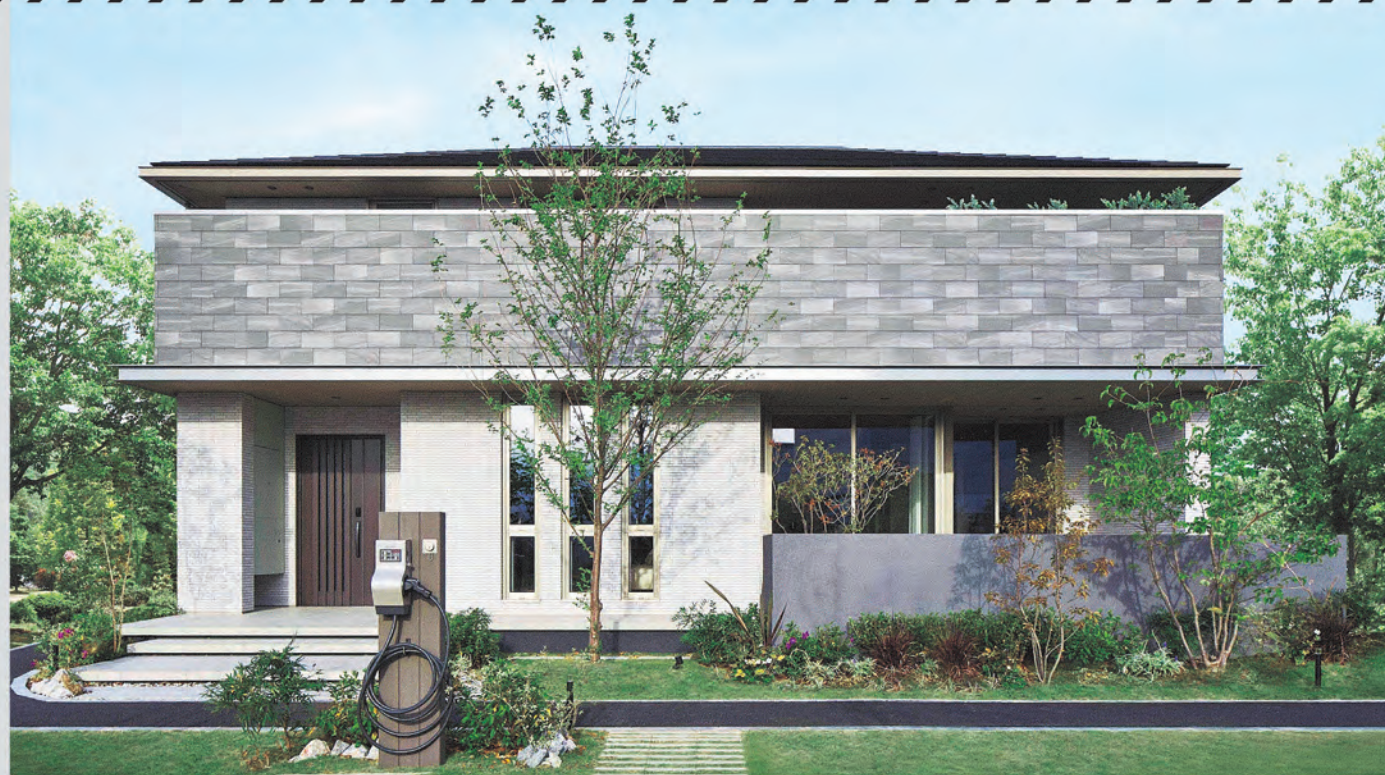
太陽光発電と蓄電池を備えた住宅
