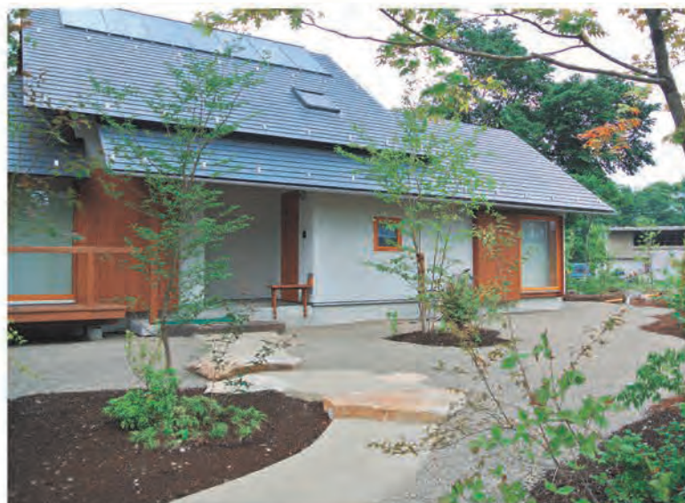
パッシブソーラーハウスの施工事例。屋根に設置したガラスが集熱効果を高める
