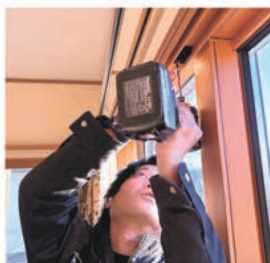
内窓を施工するクリアのスタッフ。内窓設置は簡単に作業でき、補助金の対象にもなる
