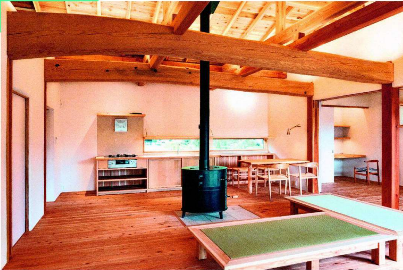
八ヶ岳産材を「太鼓梁」として用いた住宅。一本一本異なる曲がりや、唯一無二の個性を生み出している
