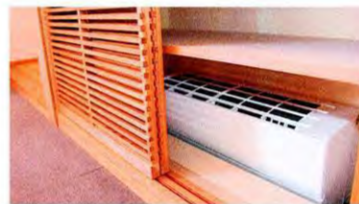
床下に収納したエアコン。この1台ですべての部屋の空調がまかなえます
